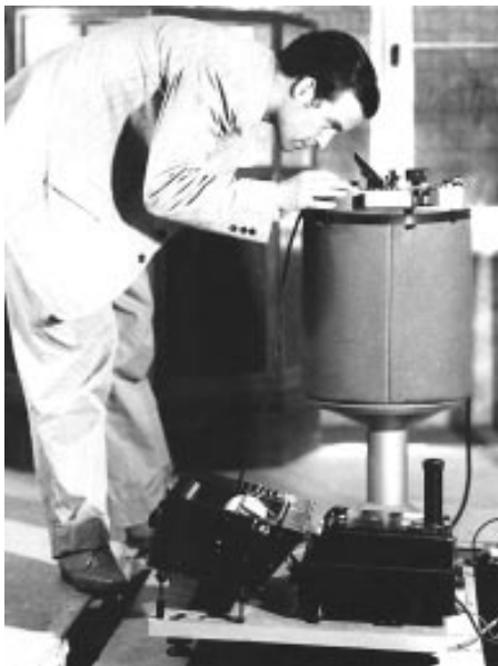
Abb. 3 Gezeitengravimeter Askania GS 12
