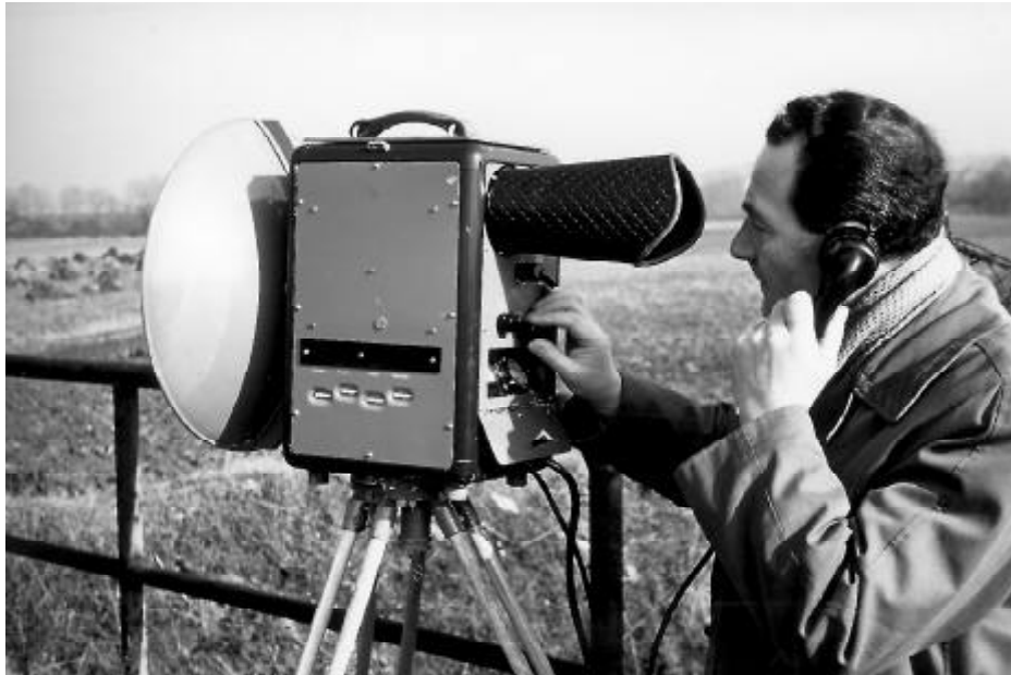
Abb. 3 Einsatz des Tellurometers MRAI 1958
