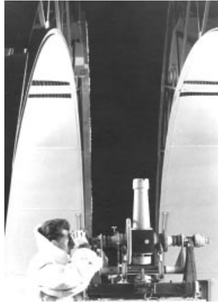
Abb. 4 Astronomische Zeitbestimmung mit Askania-Meridianinstrument
